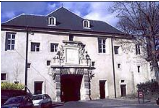
Porte de la Citadelle دروازه سیتادل
